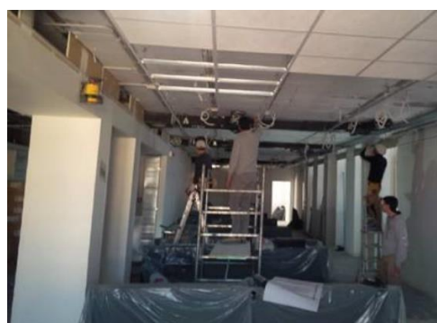
Figura 8.2 - Particolare installazione controsoffitti
