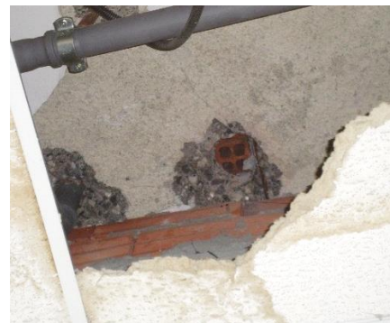
Figura 4.2 - Particolare della porzione di involucro – solaio e muratura esterna
