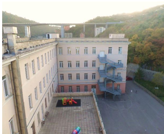
Figura 1.1 - Vista della facciata esposta verso il cortile interno
