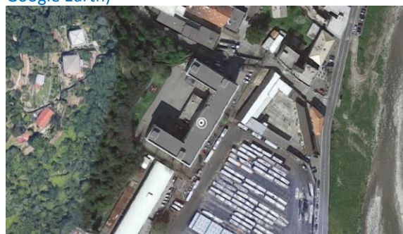
Figura 2.2 - Vista satellitare dell'edificio (Fonte: Google Earth)
